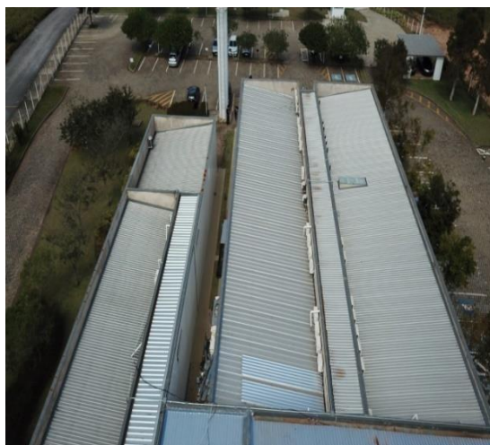
Vista aérea do telhado
