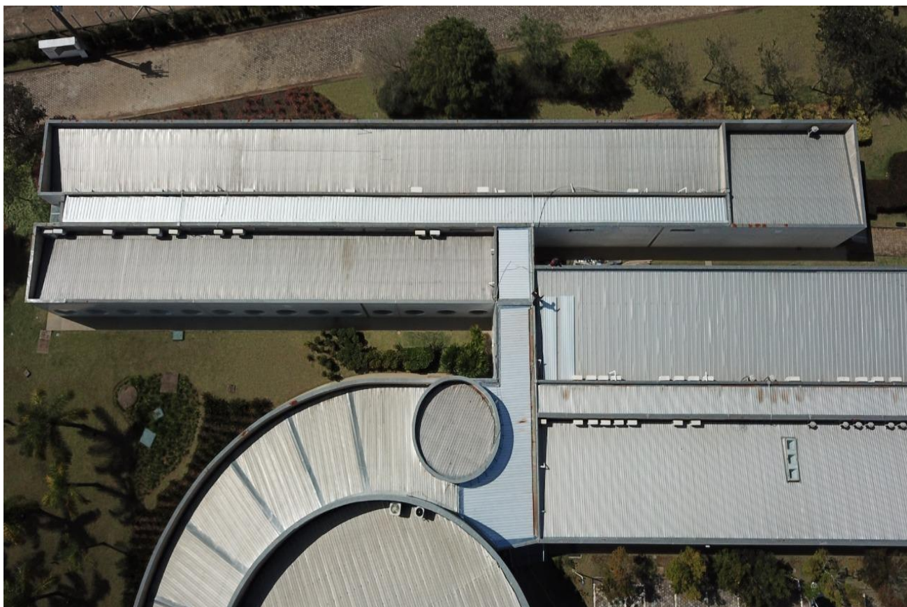
Visão aérea - Telhado
