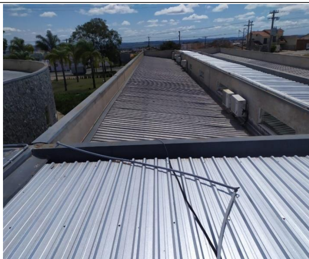
Visão Geral do Telhado
