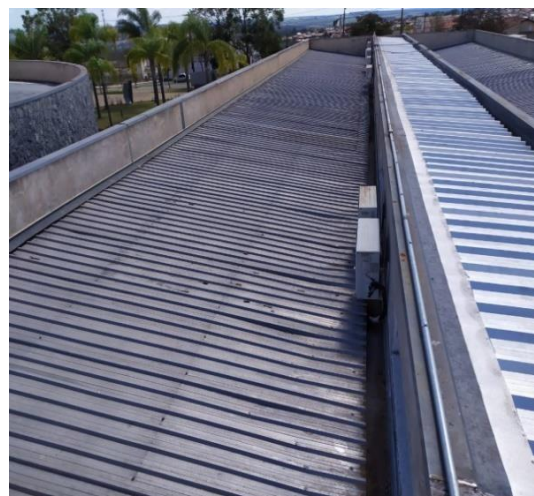
Visão Geral do Telhado
