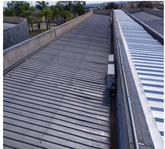
Visão Geral do Telhado
