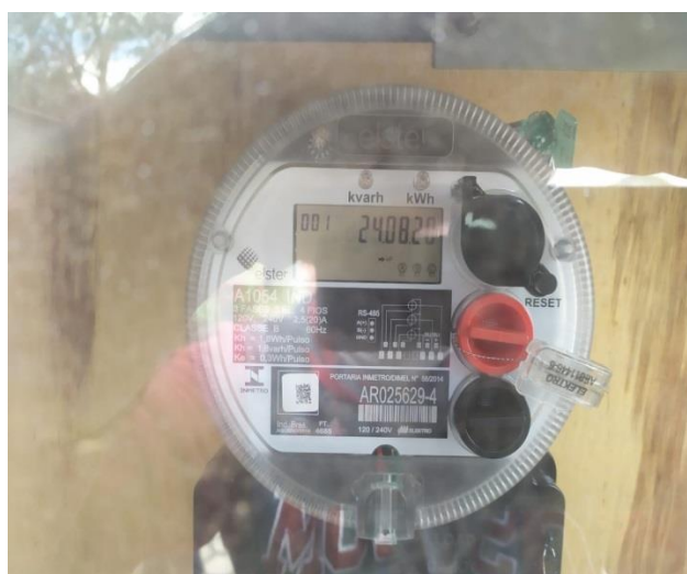
Medidor de Energia
