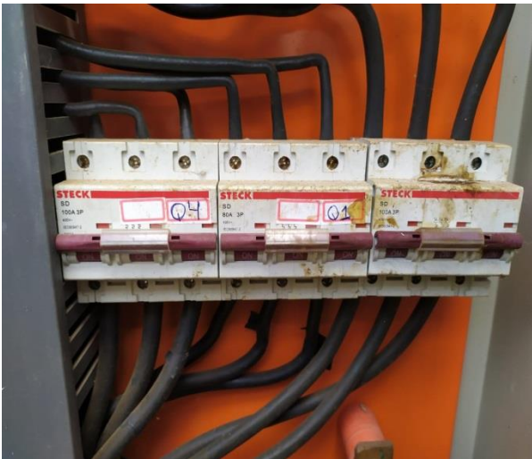
Disjuntores – Quadro Secundário
