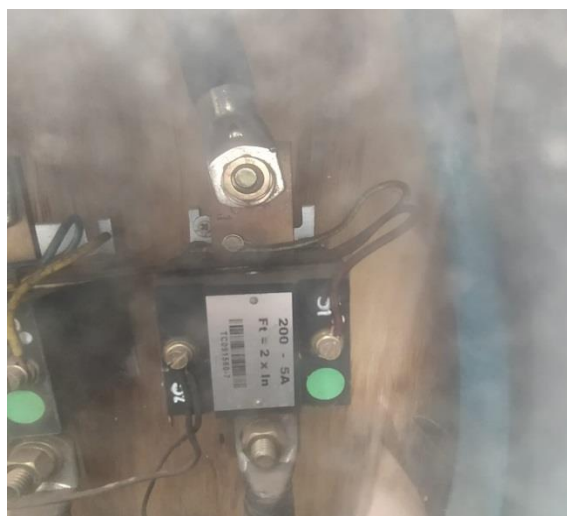
Transformador de Corrente
