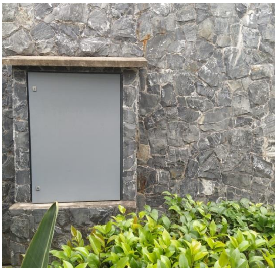
Quadro de energia Secundário
