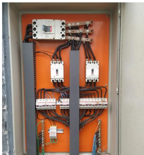
Visal geral – Quadro Secundário
