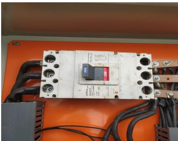
Disjuntor Geral – Quadro secundário 250A
